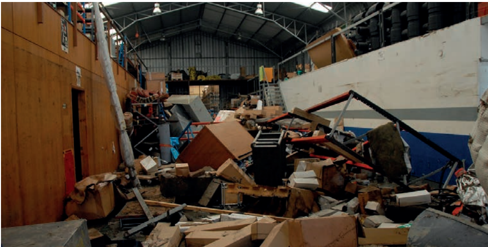
Daños en interior de Almacenes de Construcción Naval
