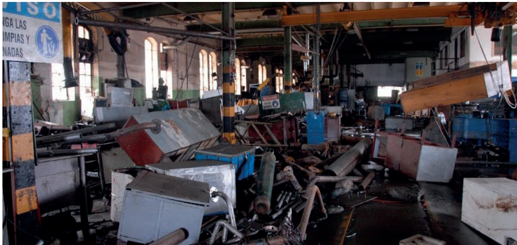
Estado del interior del T-63
