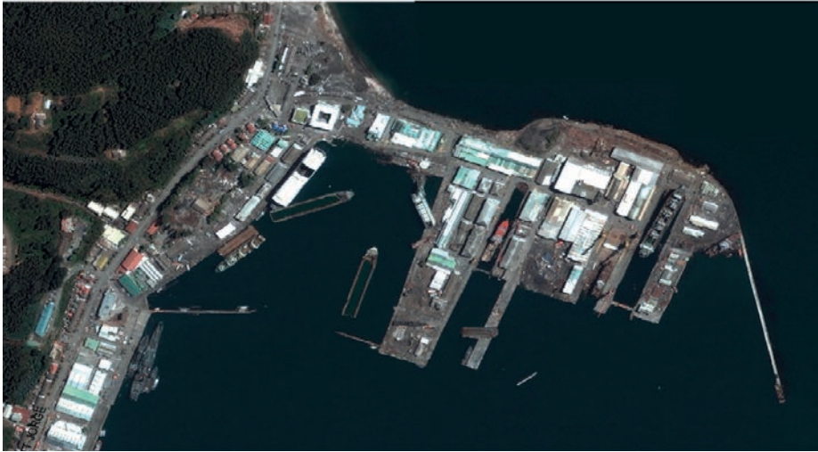
Vista aérea de daños en Asmar (T)
