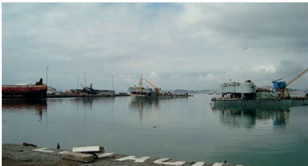
Diques flotantes hundidos en la Dársena de Reparaciones
