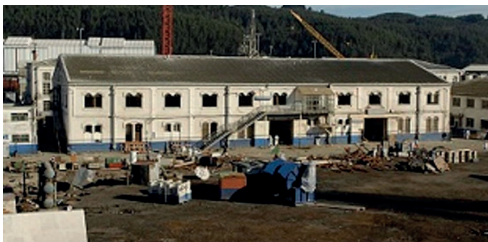
Edificio de Construcción Naval y T-63 en 1er piso - Debió ser demolido completo
